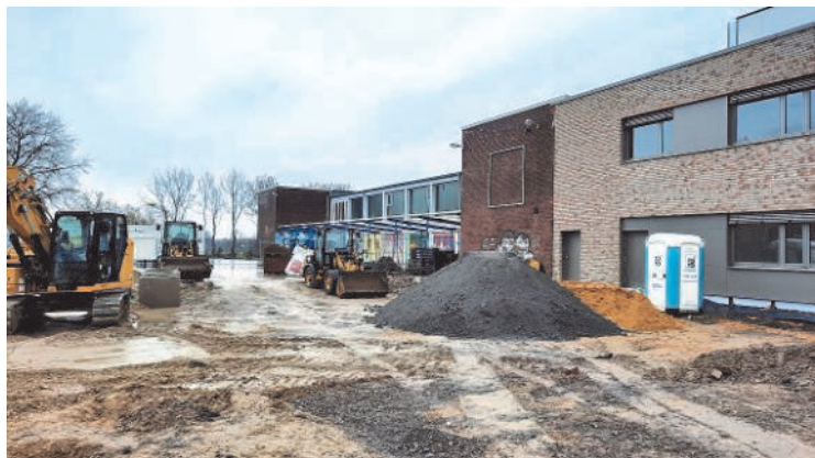
Auch aktuell ist die Altfriedschule eine große Baustelle. Sie wird um 4 Klassen, etwa 100 Kinder, erweitert.
